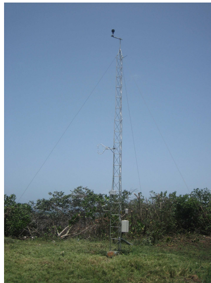
Figure 8 : Disposition des capteurs et centrale de mesure sur le mât de 10 m
